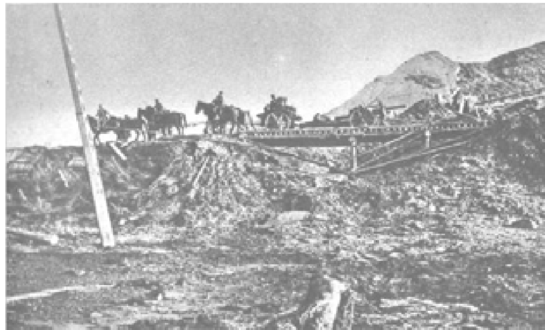
An anderen Stellen haben unsere Pioniere Notbrücken an Stelle der von den Belgiern gesprengter Brücken errichtet, und der Vormarsch geht unaufhaltsam weiter
