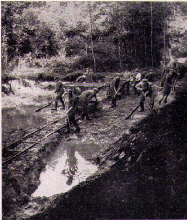
Stadtforst Pyritz wird entwässert
