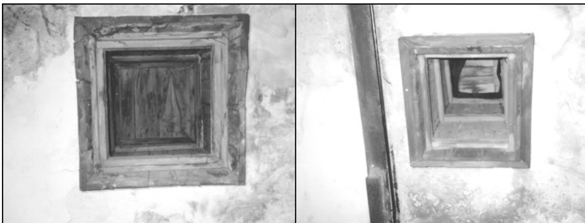
Obr. 5 a 6: Východní (vlevo) a západní (vpravo) otvory ve stropě odvěšivovacího zařízení v baráku 41 (porovnej mapu, obr. 1). © C. Mattogno
