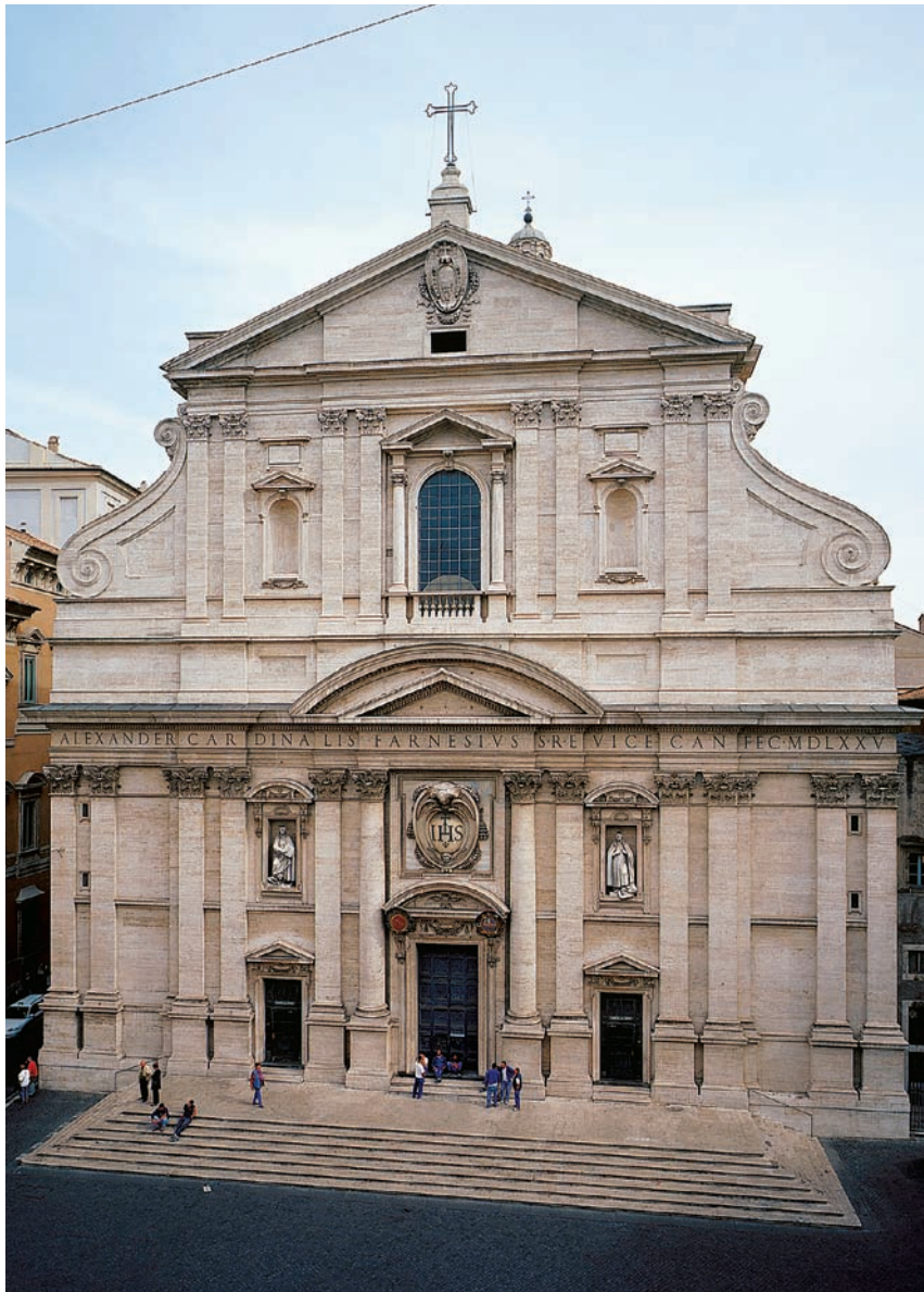
22-56 Giacomo della Porta, west facade of Il Gesù, Rome, Italy, ca. 1575–1584.
