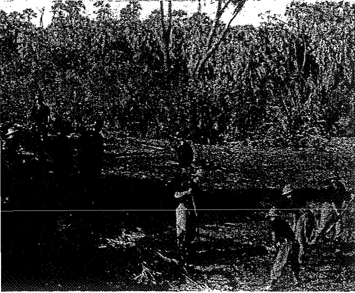
Ein Durchbruch durch den Urwald wird eröffnet
