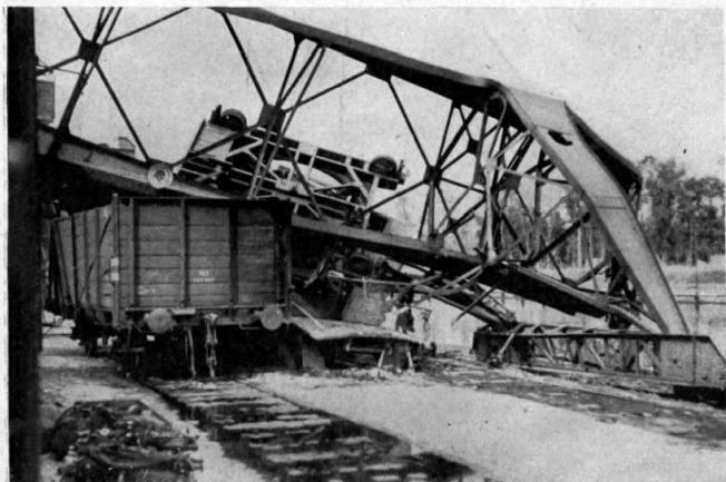
Zerstörter Kran am Hafentai in Neufahrwasser.
