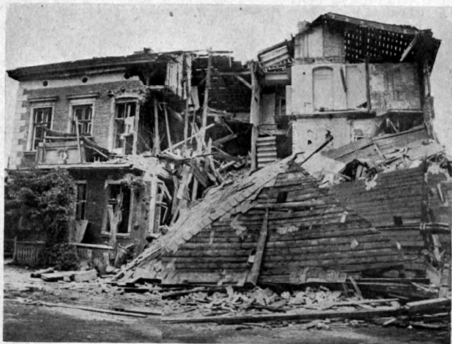
Eingestürzte Häuser in Neufahrwasser.
